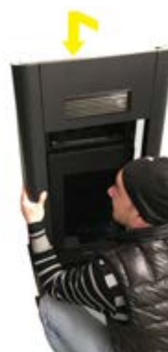
Fig. 24 - Posizionamento della cornice
