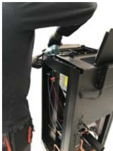
Fig. 29 - Rimozione compensatore
